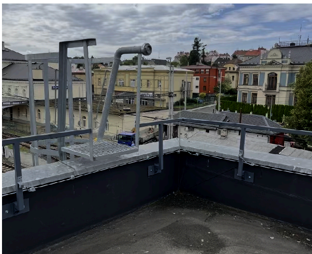
Obrázek 5 - Výlez na střešní konstrukci
