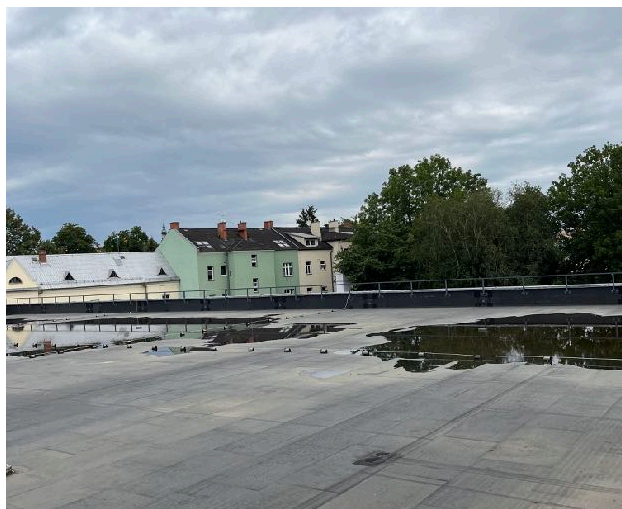
Obrázek 6 - Střešní konstrukce z mPVC krytinou
