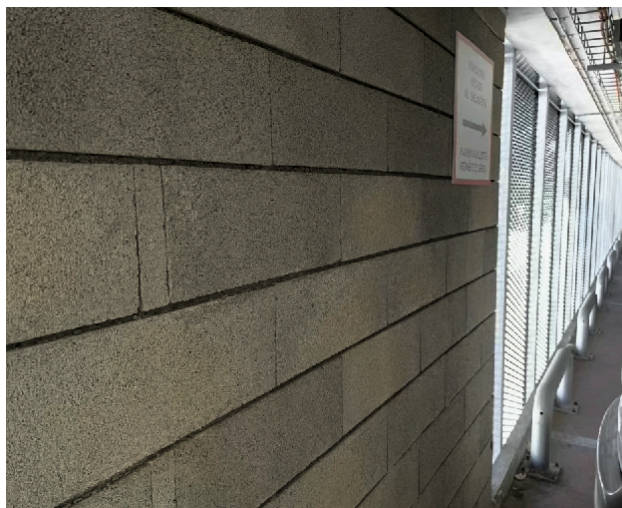
Obrázek 3 - Vyzdívka ze ztraceného bednění
