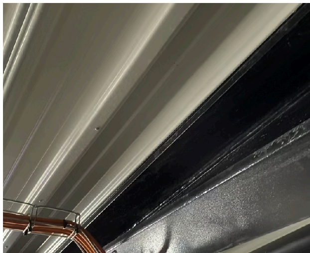
Obrázek 2 - Stropní konstrukce z trapezového pohledového plechu
